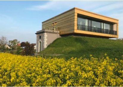
Hochbehälter Ockerwitz (Foto: Hochbehälter Ockerwitz)
